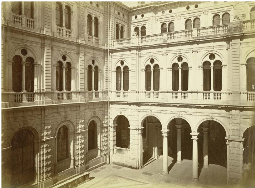
Cortile interno della sede della Cariplo in via Monte di Pietà a Milano, 1872 (Pompeo Pozzi)
